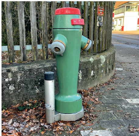
Zwei neu montierte «LORNO Communication Units» mit ihrer Antenne, welche vom unterirdischen Hydrophon gemeldete Unregelmässigkeiten weitergeben.
